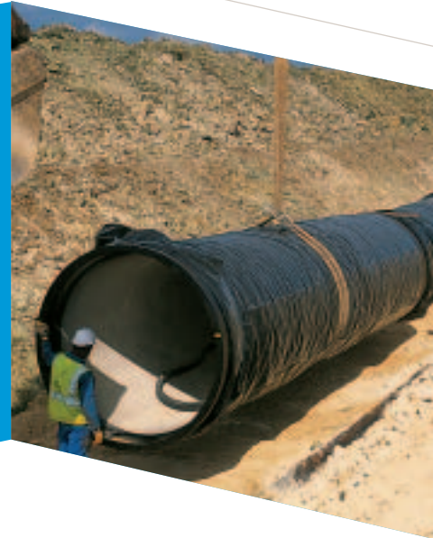
Sobea Environnement a poursuivi le chantier de réhabilitation des aqueducs alimentant Paris.
