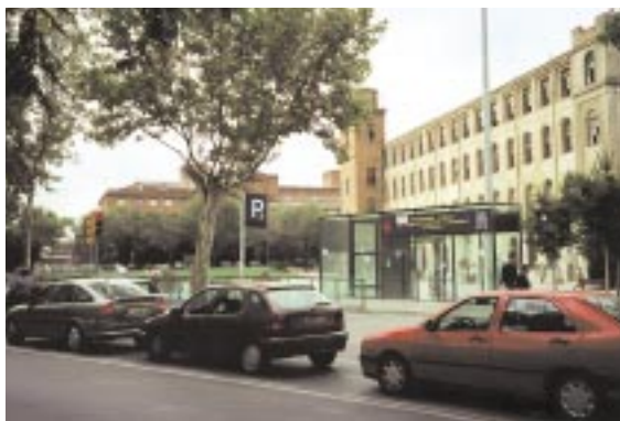
Trémie d'accès des véhicules et émergence de l'ascenseur du parc de la place Can Fabra à Barcelone (Espagne, Aparcamentos de Cataluña SA).
